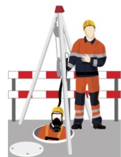
Рис. 4. Страховка работников при помощи треноги
